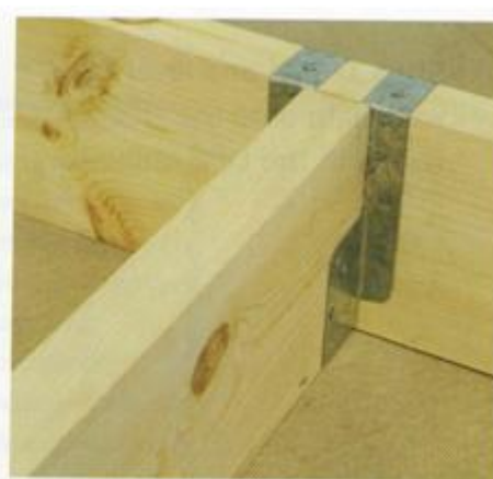
根太受け金物（joist hunger）
