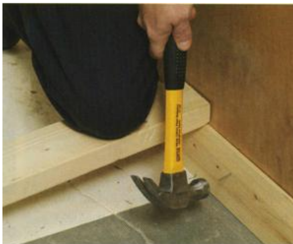
膝当て板を使い釘留め
