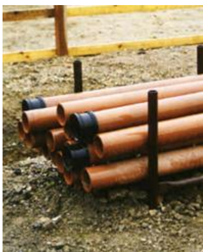
積み重ねられた排水管
