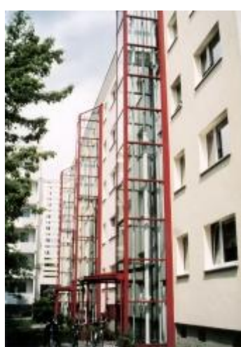
階段室型住宅へのエレベーターの設置
