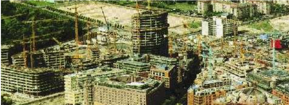
ポツダム広場の再開発現場
