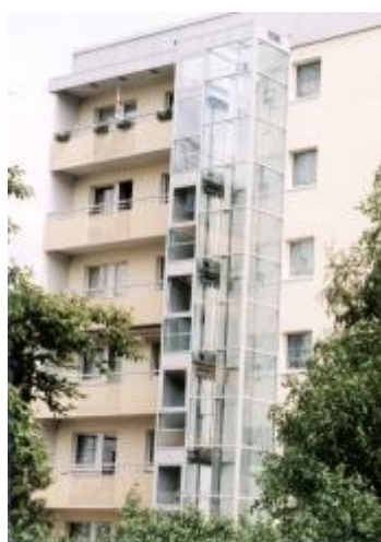
廊下型住宅へのエレベーター設置
