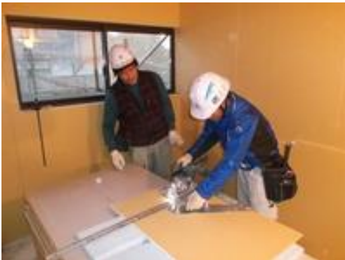
外国人技能実習生の大工作業風景
