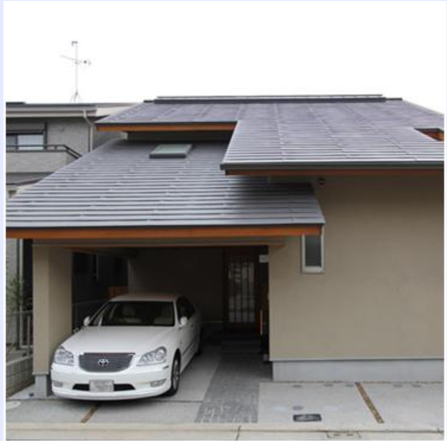
(コアー建築工房)
