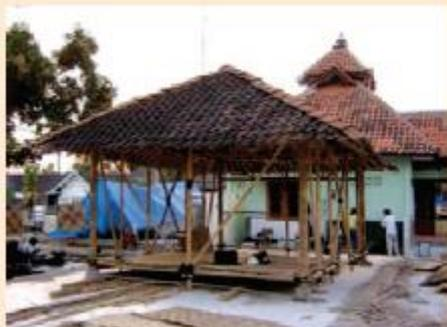
仮設住宅の「屋根を先に建設」戦略は、ジャワ島中部地震後（2006年）にジョクジャカルタに導入された。住民の頭上にある屋根の設置を優先し、その後、徐々に仮設住宅を完成することができた。一方、恒久住宅の再建については、多数の被災者にできるだけ早急に構造上安全な最低限度の広さの恒久住宅（コアハウス）を提供し、その後、被災者がその住宅を徐々に拡張するという手法が取られた。
