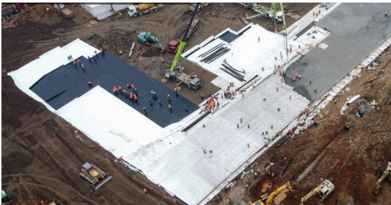
ジオテキスタイルの上に、補強鉄筋をメッシュ状に並べ、コンクリートを打設する。
