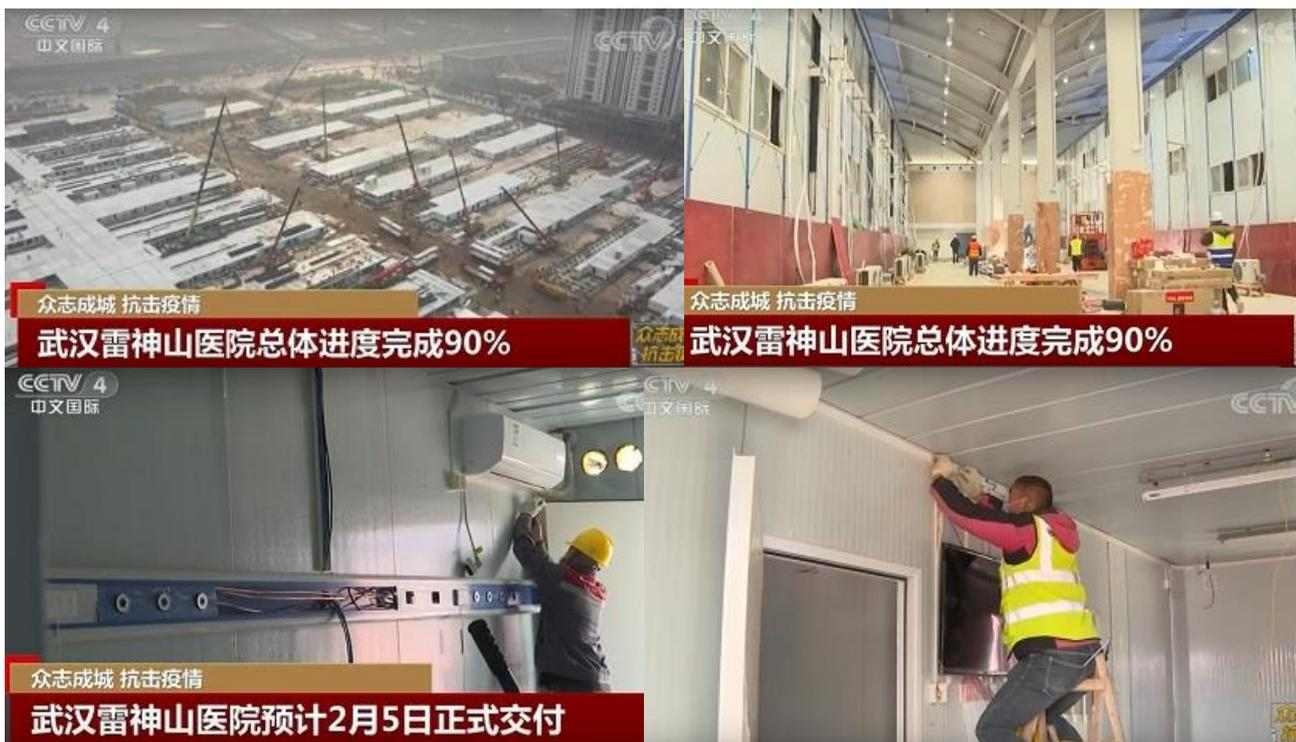
雷神山医院の医療スタッフ寮は、鉄骨方立パネル構造で、日本の応急仮設住宅の規格型と似たもので、仕上りの品質はあまりよくない。しかも鉄筋のブレースが露出されている。
