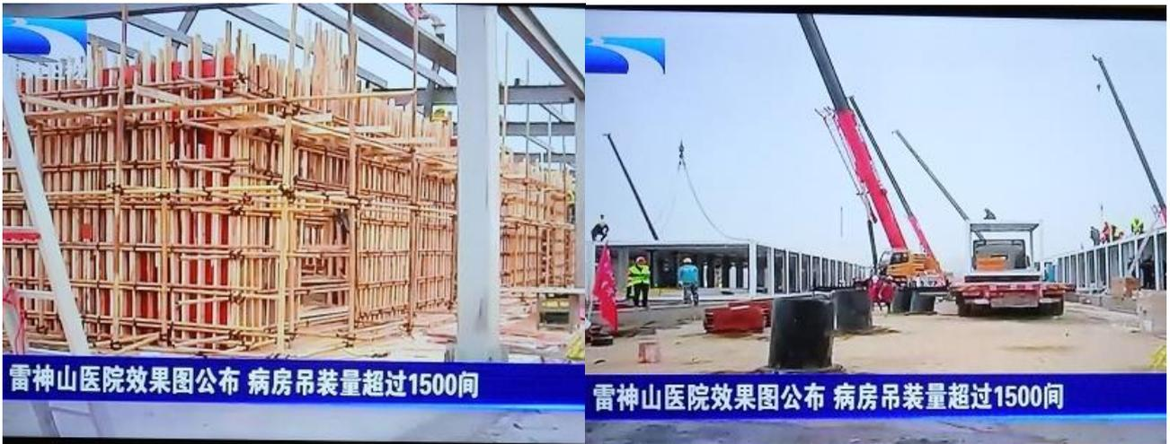
鉄筋コンクリートの型枠も見える。支保工は竹製である。
