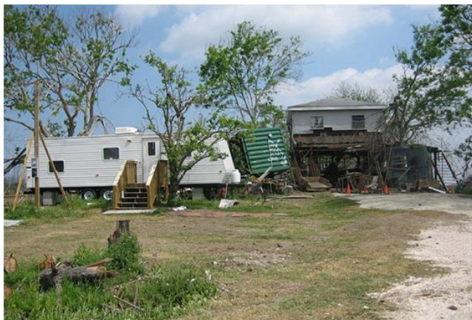
ルイジアナ州セントバーナード郡、カトリーナによる損傷を受けた家と FEMA のトレーラー（左側）
